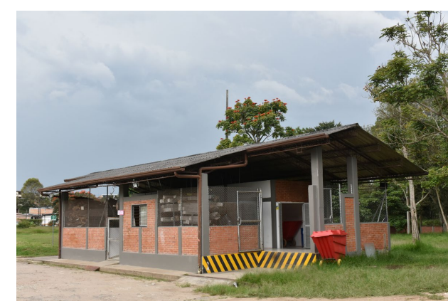
Edificio Almacenamiento de Residuos
