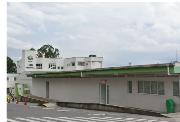
Edificio Almacén y Archivo
