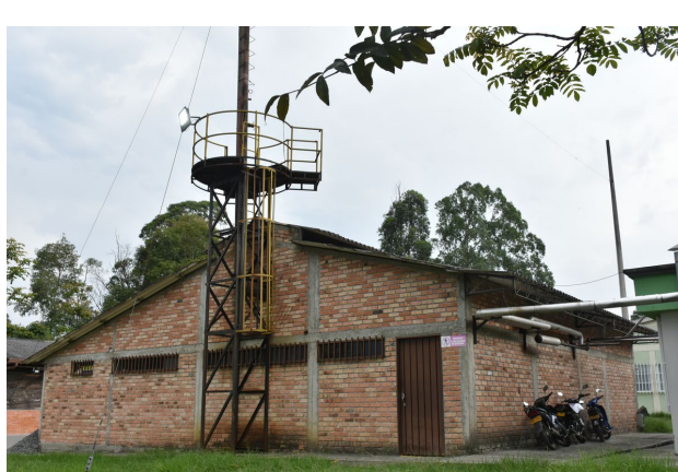
Edificio de Calderas
