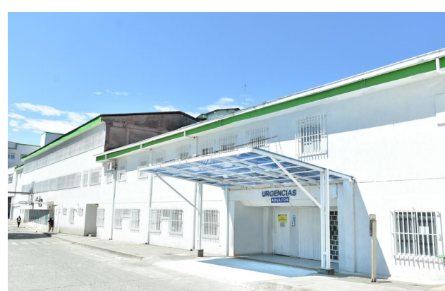
Edificio Urgencias adulto
