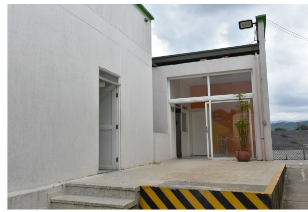
Edificio Central de Gases
