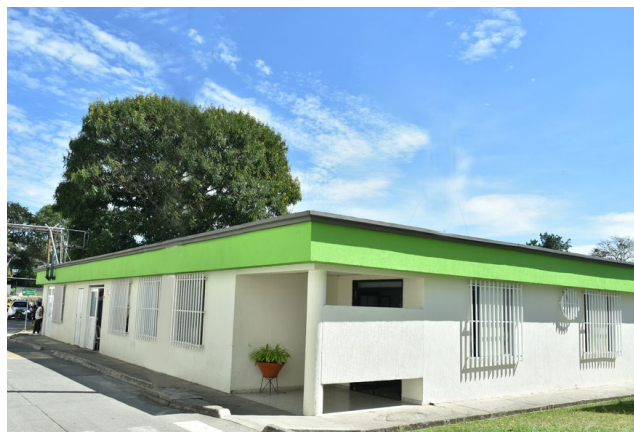
Edificio Servicio de Lavandería
